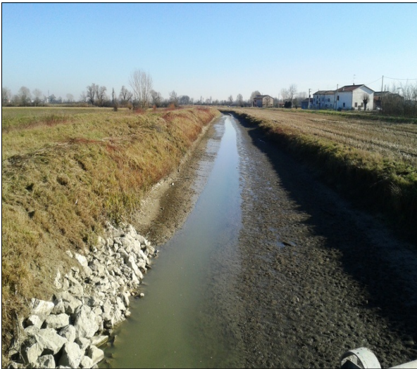
Collettore Alfieri canal before the works
